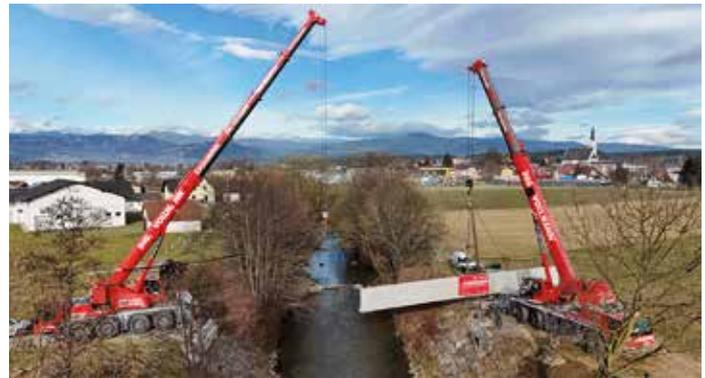
Montage der Halbfertigteilebrücke durch die Firma „Ing. Vollmann - Fertigteilewerk GmbH“ (Foto: Stefan Vollmann)
